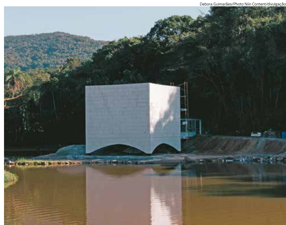
Vista da construção da galeria de Laura Belém no Museu Bernardo Paz
