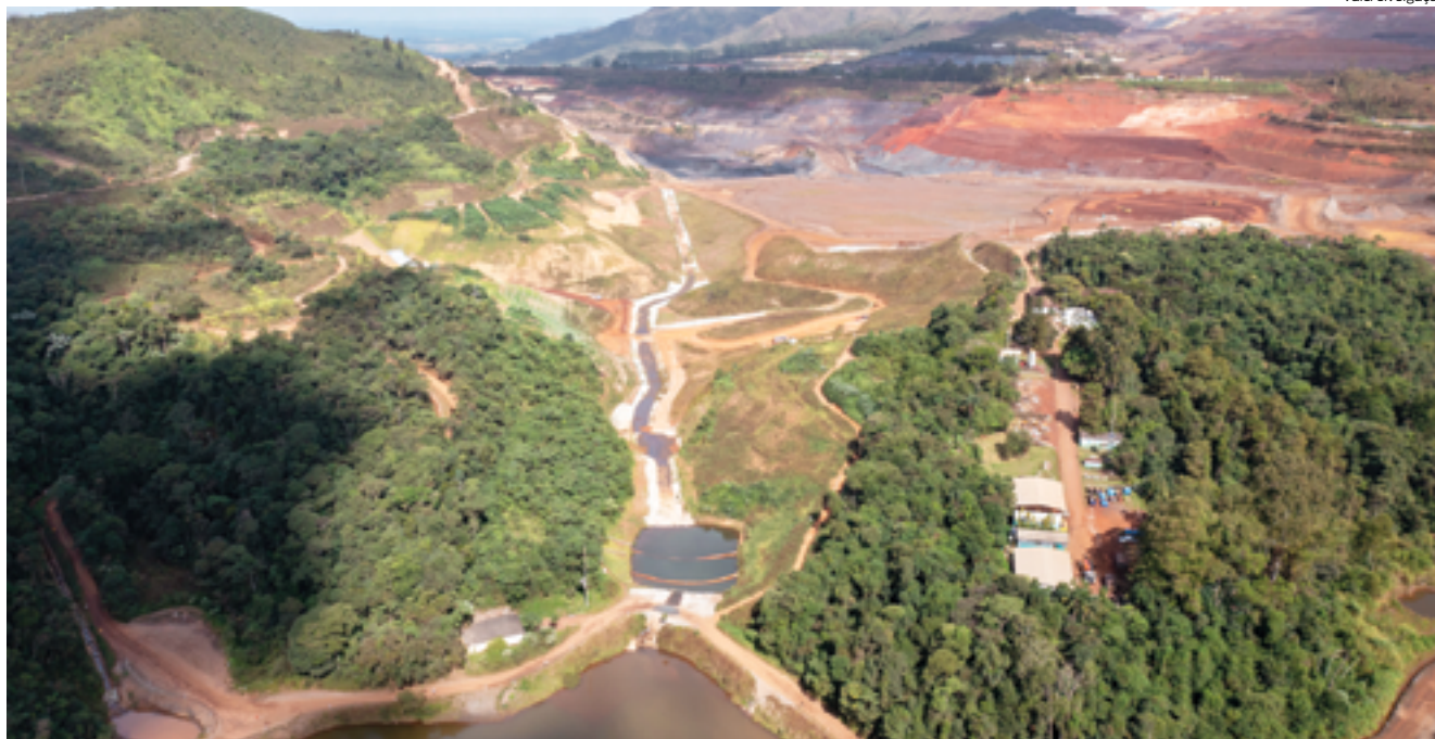
A barragem Grupo, localizada na Mina Fábrica (Complexo de Ouro Preto/MG), é uma das estruturas a montante da Vale que teve as obras de descaracterização concluídas
