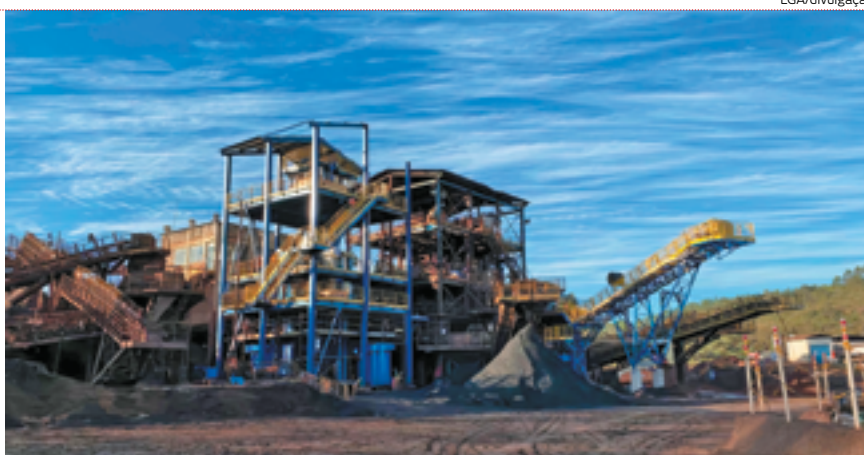
Planta da mineradora LGA; companhia reaproveita 95% da água utilizada nas operações
