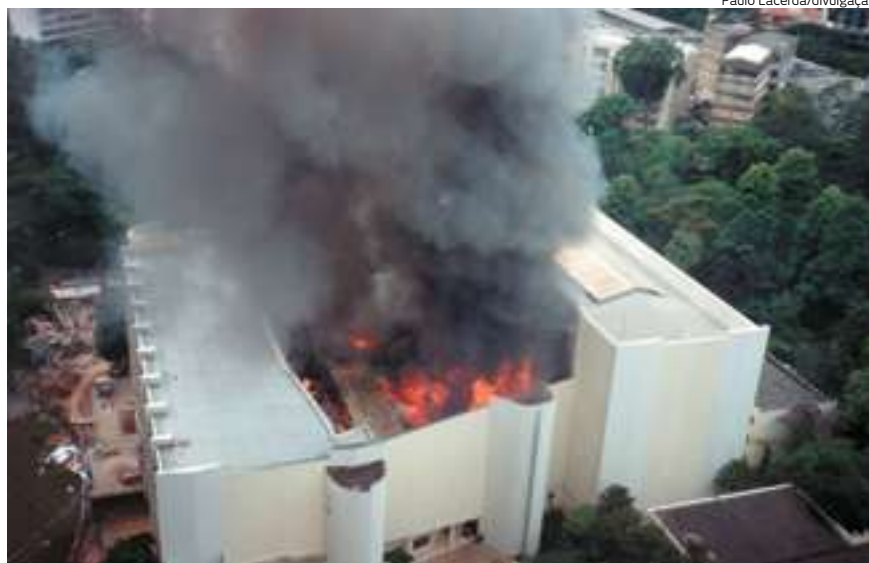
Incêndio atingiu o prédio da instituição em abril de 1997 e marcou de forma trágica a trajetória da instituição
