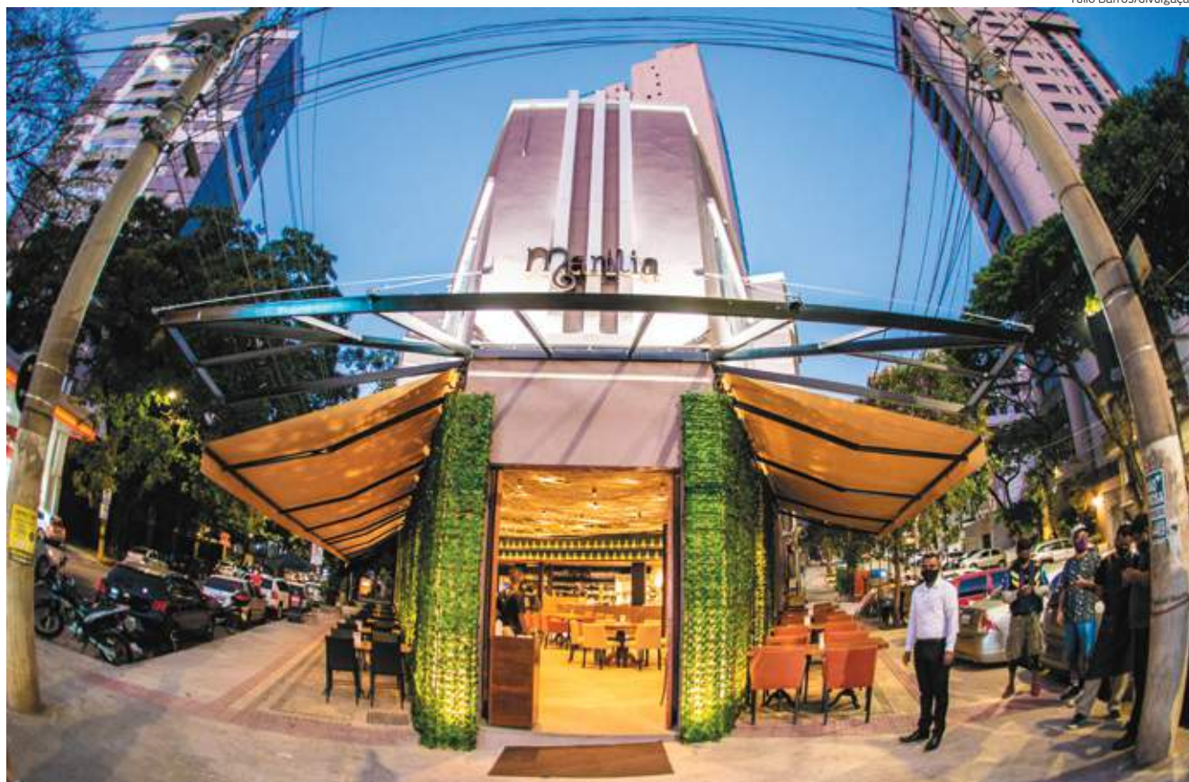
Agora Marília Forneria e Empório, a tradicional casa que ficava na rua Marília de Dirceu ganhou novo nome, endereço e proposta: seis meses de obras
